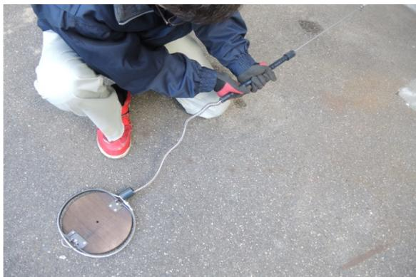
⑦ 後スプリングガードを落とし方向に引張りスプリングをガードに納める
